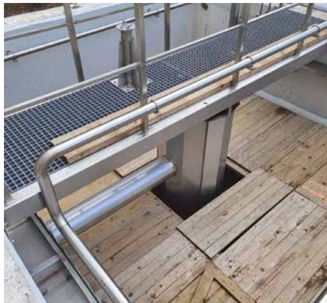
Vystrojení při rozšíření ČOV
