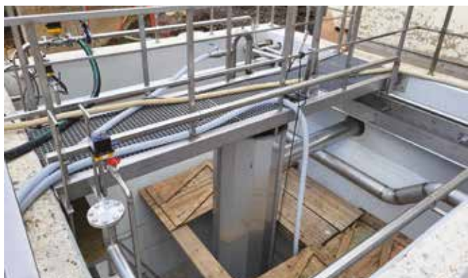
Vystrojení při rozšíření ČOV
