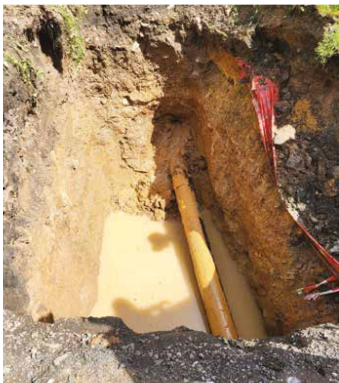
Podvrt pod silnici u bytovek pro vodovodní přívadeč od Záruby do Kozojed
