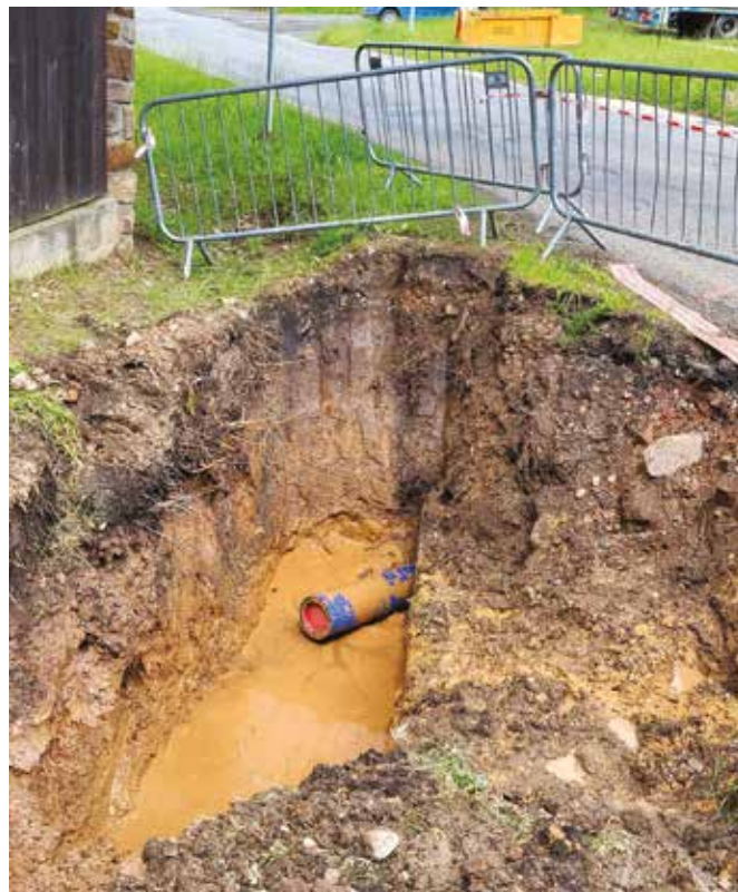
Podvrt pod silnici u bytovek pro vodovodní přívadeč od Záruby do Kozojed
